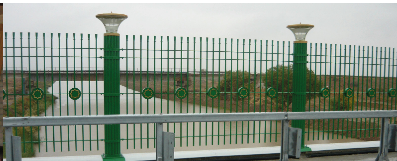
Освещение моста через реку г. Ашхабад
