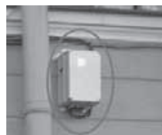
На фасаде здания
